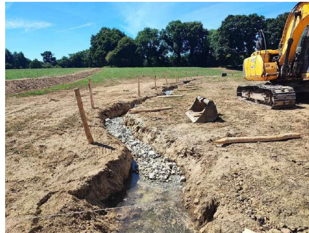
Travaux de remise à ciel ouvert du cours d'eau en juillet 2022
