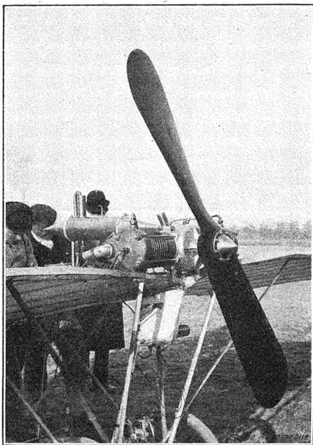
FIG. 199. — La partie moto-tractrice de la deuxième Demoiselle de Santos-Dumont (hélice en bois, intégrale, Chauvière).
